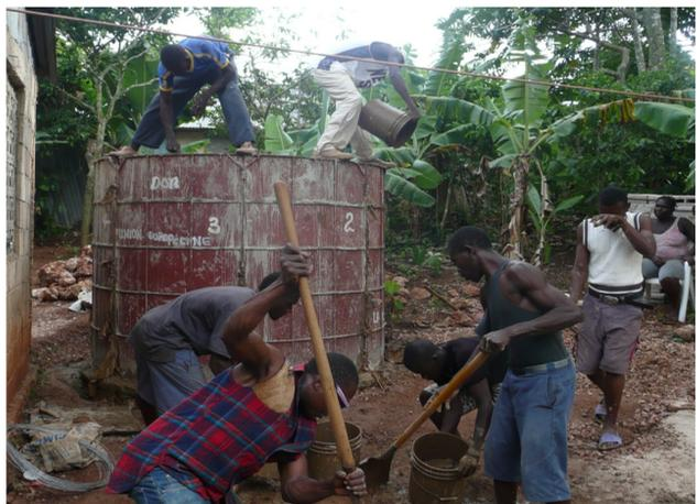
Les banches et le ferrailage font une construction antisismique. La citerne contiendra 6500 litres d'une eau collectée grâce aux gouttières des toits. L'eau sera traitée au chlore et la citerne sera nettoyée régulièrement selon un cahier des charge précis.
